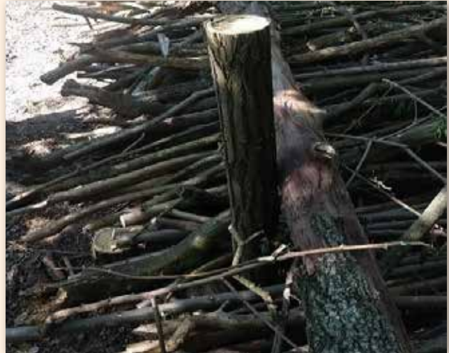
Κατασκευή κορμοφράγματος στο αρχικό στάδιο, με τη χρήση καμένων κορμών και κλαδιών της περιοχής.
