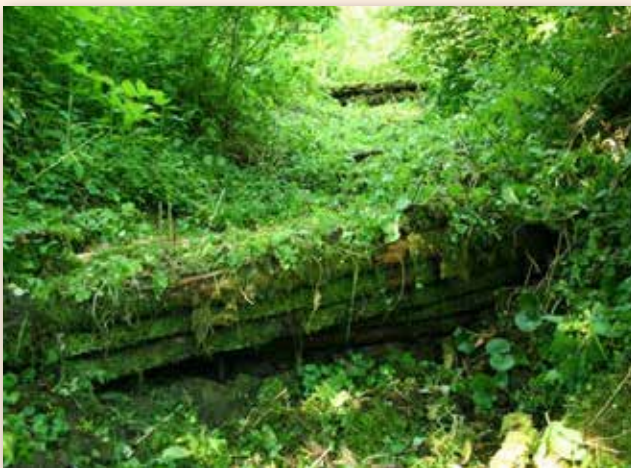
Κατασκευή κορμοφράγματος (1997) κατά μήκος κοίτης ποταμού (πάνω) και η ίδια περιοχή μετά από μια δεκαετία. (κάτω)
